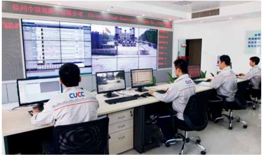
徐州中联混凝土中控室
